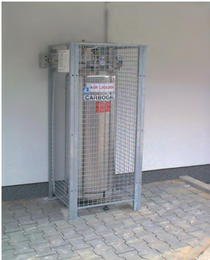
Abb. 5: Beispielhafte Aufstellung eines (stationären) Druckbehälters
