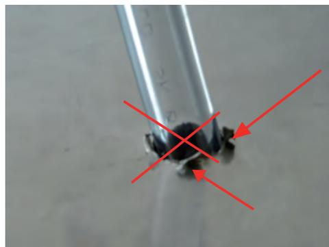
Abb. 13: Verbotene Verlegung (Bohrung nicht entgratet, fehlende Tülle oder dgl.)
