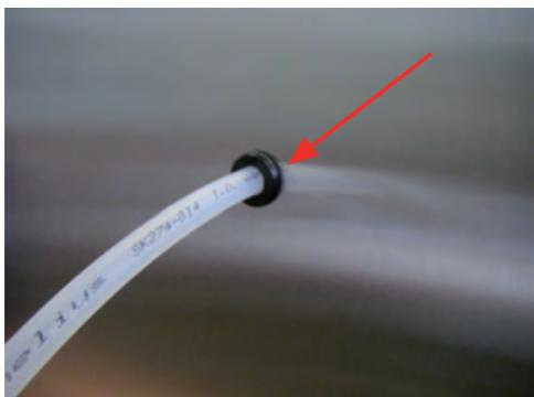
Abb.12: Beispielhafte geschützte Verlegung der Gasleitung in den Innenraum (Fasskühler, Theke)
